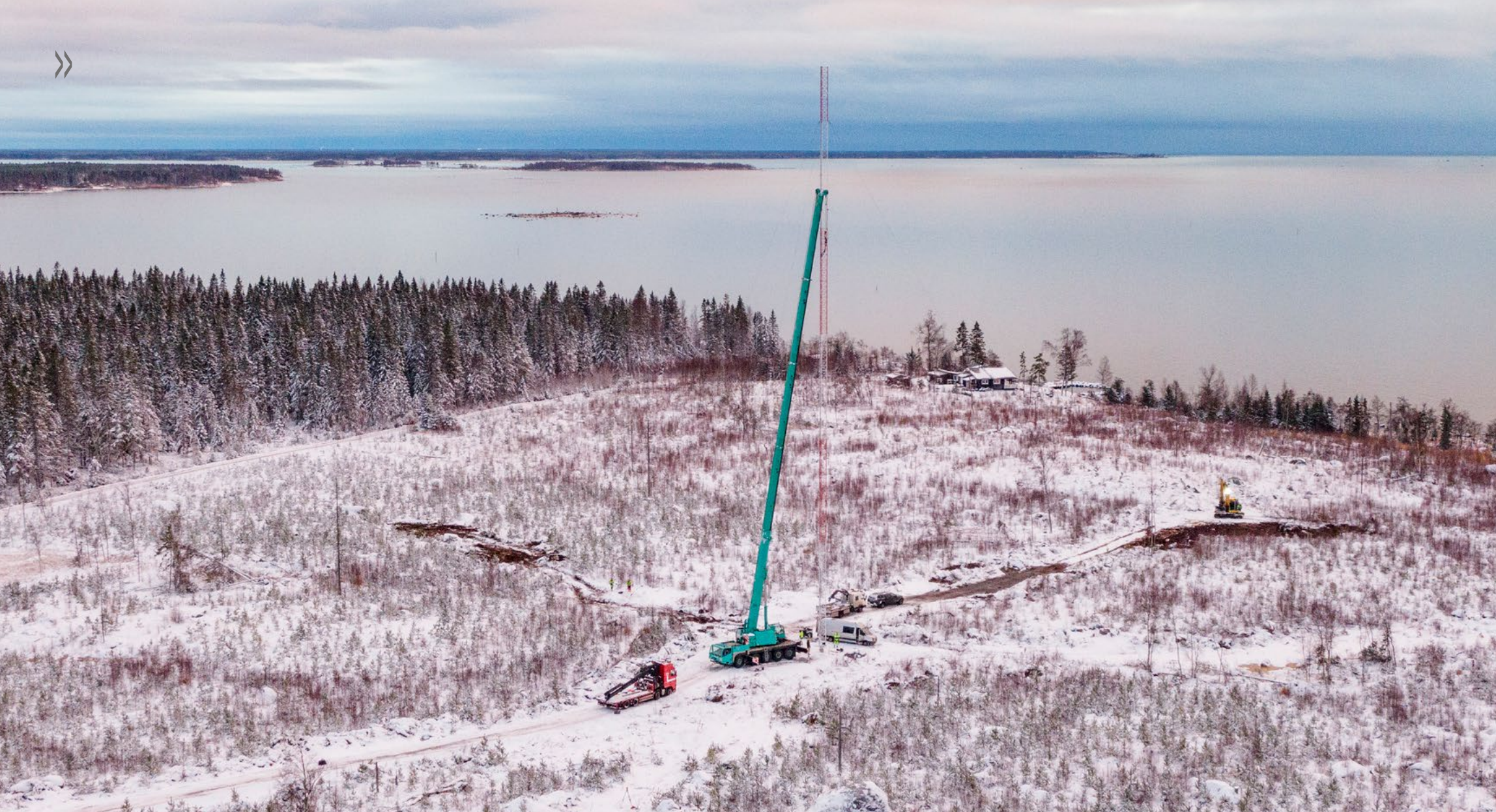
Korsnäsiin rakennettava puisto on Suomen ensimmäinen teollisen mittakaavan merituulivoimapuisto, joka sijaitsee avomerellä.
